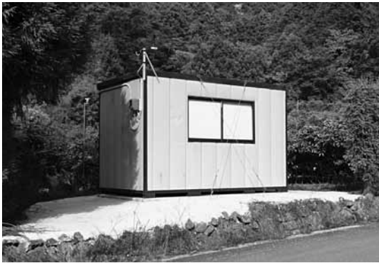
防災備蓄倉庫（天満地区）
