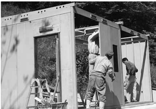
防災備蓄倉庫（天満地区）製作中
