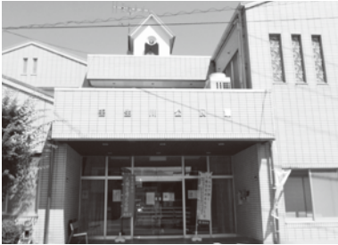
壬生川公民館の外観
